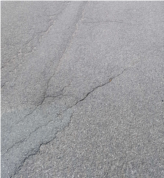
Figur 2.4 – Der er mange åbne revner på stamvejen (1).
